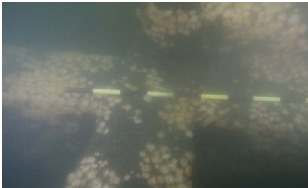
Figura 4. Restos de la estructura de hormigón del Muelle Francés aún en posición. La losa se presenta a tramos bien conservada, y en otros, parcial y totalmente colapsada.
