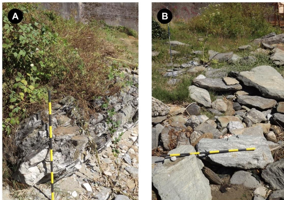
Figura 4-6. Muros de abrigo colapsados y concentraciones de bloques en Playa La Argolla. A. Vista de fragmento de muro de rocas colapsado. B. Vista de bloques de piedra dispuestos en la playa como muro de abrigo para la pleamar.
