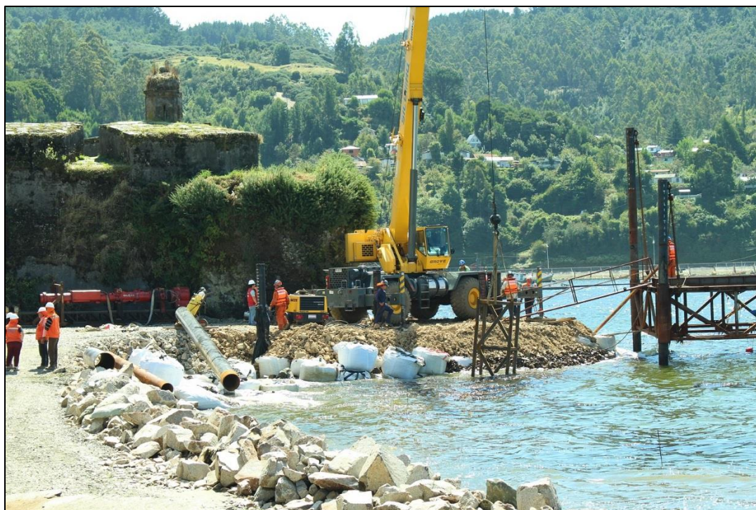
Figura 4-19. Trabajos en el Frente N°3 el 23 de febrero de 2017. El Rasgo 5 habría sido recubierto con sacas, previo al relleno del sector para el acceso de maquinaria.
