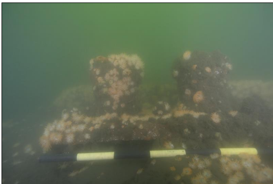
Figura 4-12. Bitas de amarre colapsadas asociadas a los restos del Muelle Francés.
