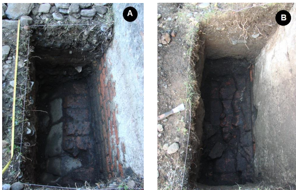
Figura 2-5. Fundaciones de la cortina del Castillo de Corral. A. Fundación de ladrillo sobre bloques canteados de piedra (sillar), Pozo 1-2. B. Fundación de ladrillos escalonados, Pozo 3-4. (Unidades: 140 x 80 cm). [Fuente: ÀRKA 2010: 81, Figuras 42-43]
